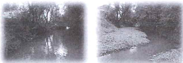
Avant / Après – Les aménagements s'effacent en crue et n'ont pas d'effet sur les débordements.
